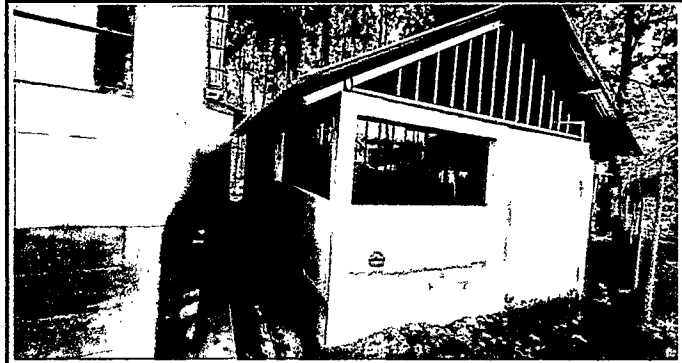
FOTO 10: Avance de instalaciones de ventanas con balcones de la cocina.
